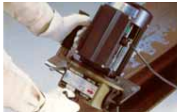
снятие фаски с кромки двутавровой балки
